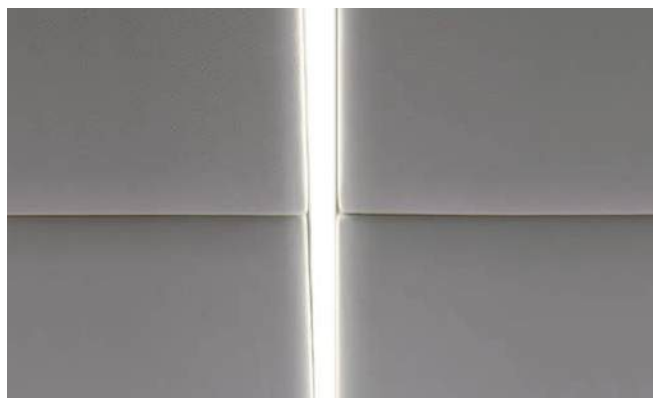
Installazione della barra tra pannelli. Installation of the bar between panels.
